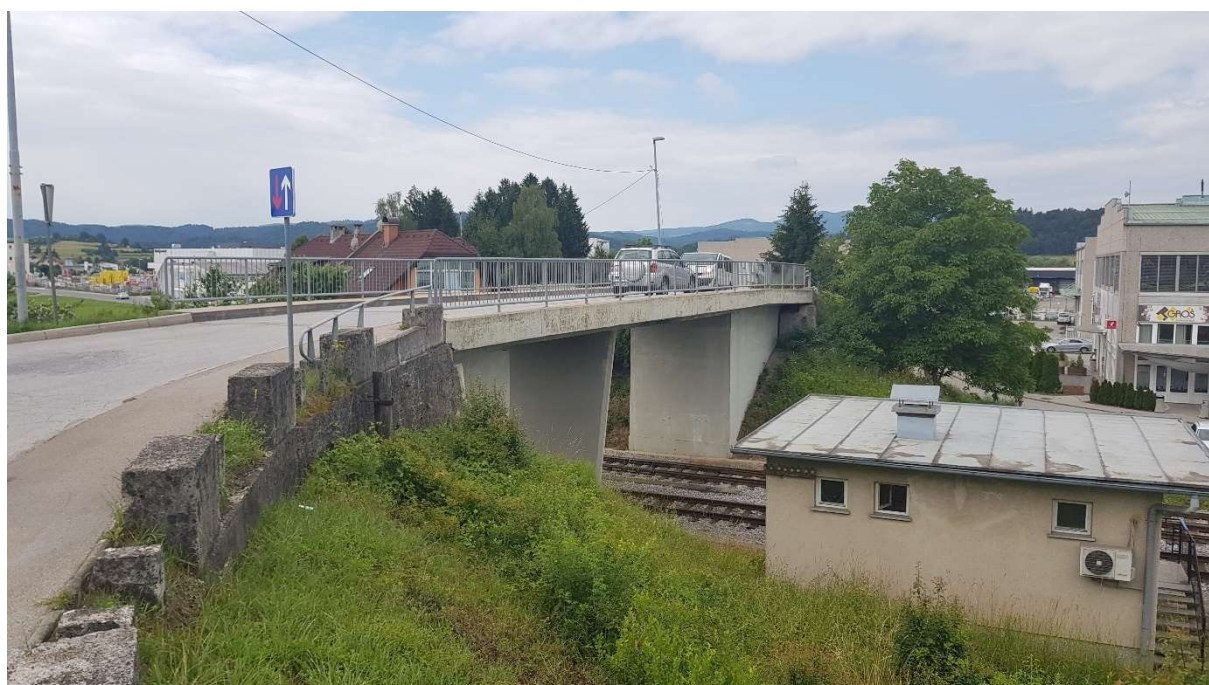
Slika 2: Pogled na obravnavano območje: lokacija obstoječega železniškega nadvoza
