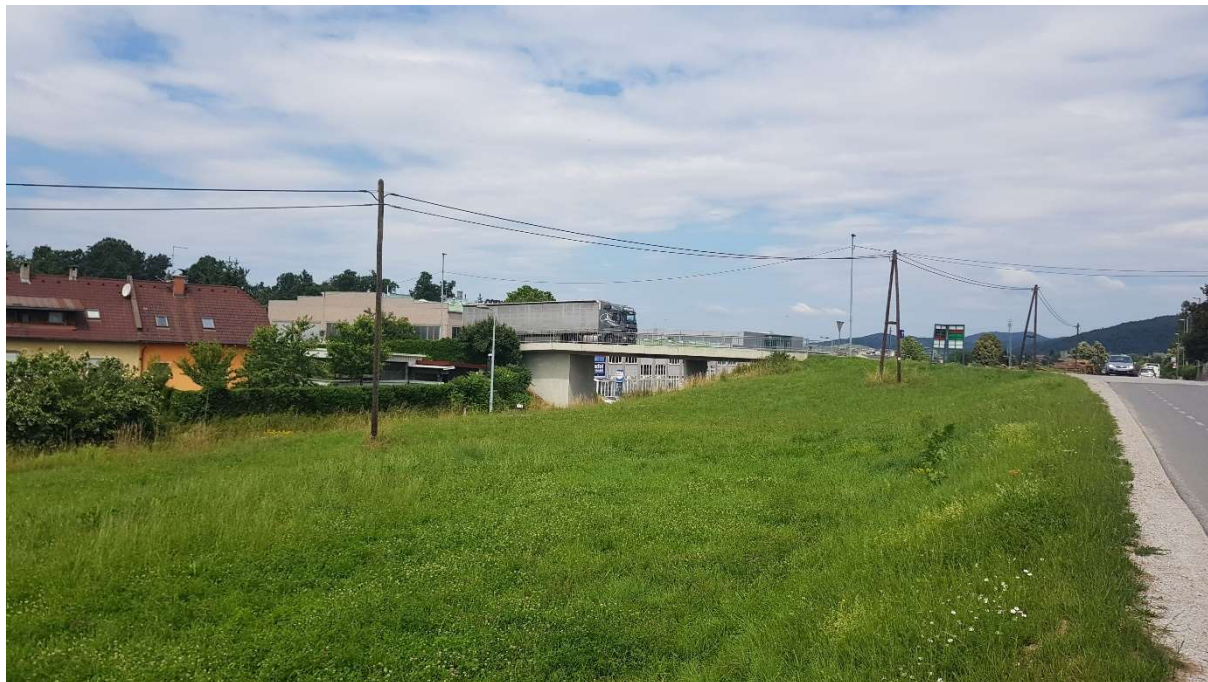
Slika 3: Pogled na obravnavano območje: lokacija obstoječega železniškega nadvoza
