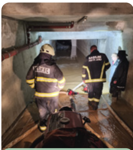
Črpanje vode in mulja iz podzemne garaže v Mengšu
